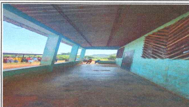
Foto 2: Reparacion Escuela de Párvulos
