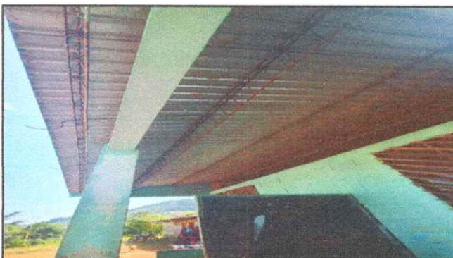
Foto 4: cambio de Techo
