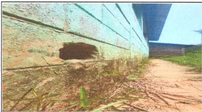
Foto 3: Reparación de Paredes
